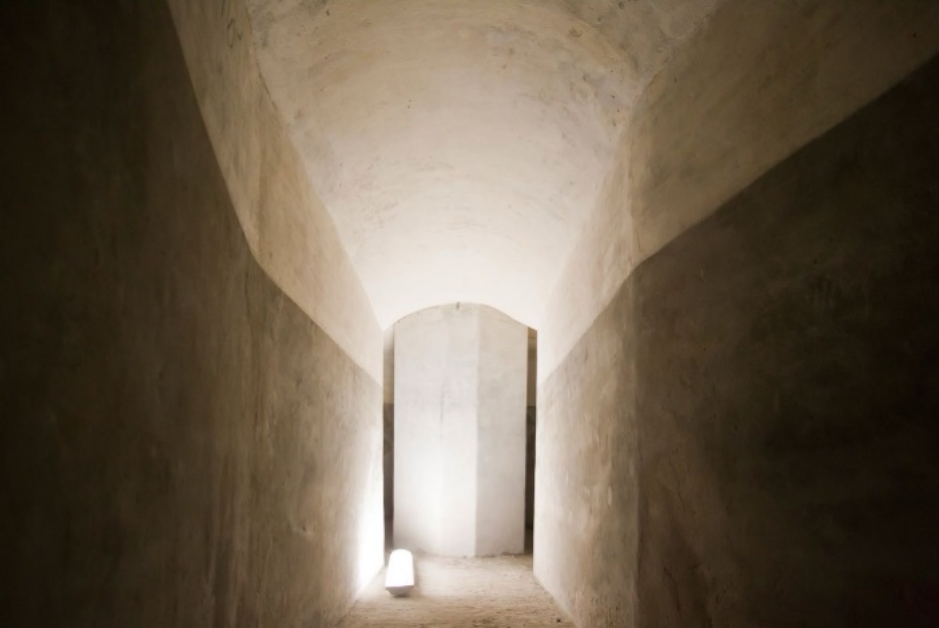
Pilar central en el pasillo de salida del refugio de Bombas Gens Foto: Daniel Rueda.
