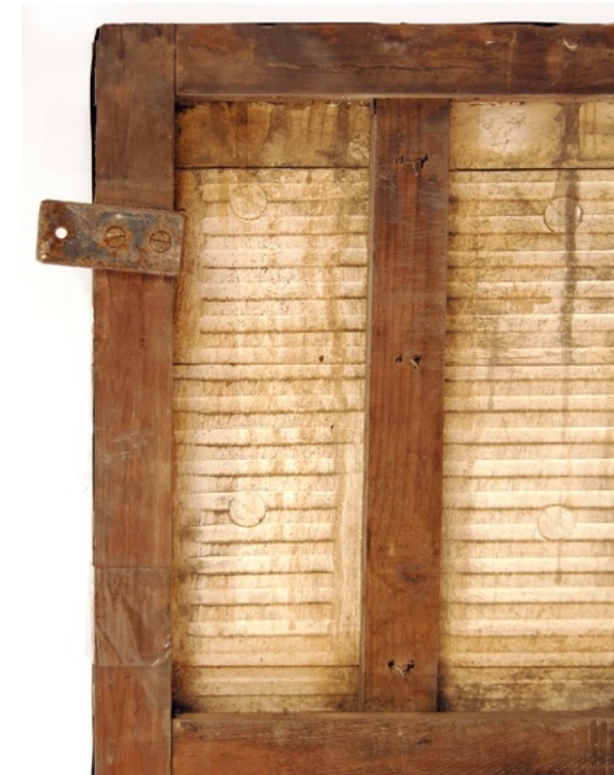
Bastidor de madera para el montaje de los azulejos que componen el panel cerámico.
