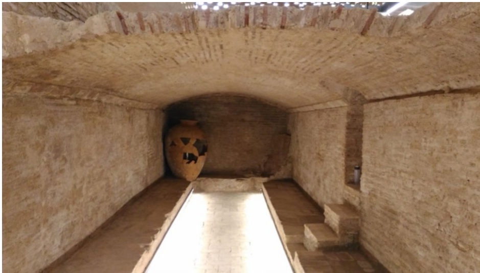
Bodega tras la intervención de restauración.
