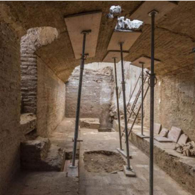
Estado de la bodega al inicio de los trabajos de restauración.
