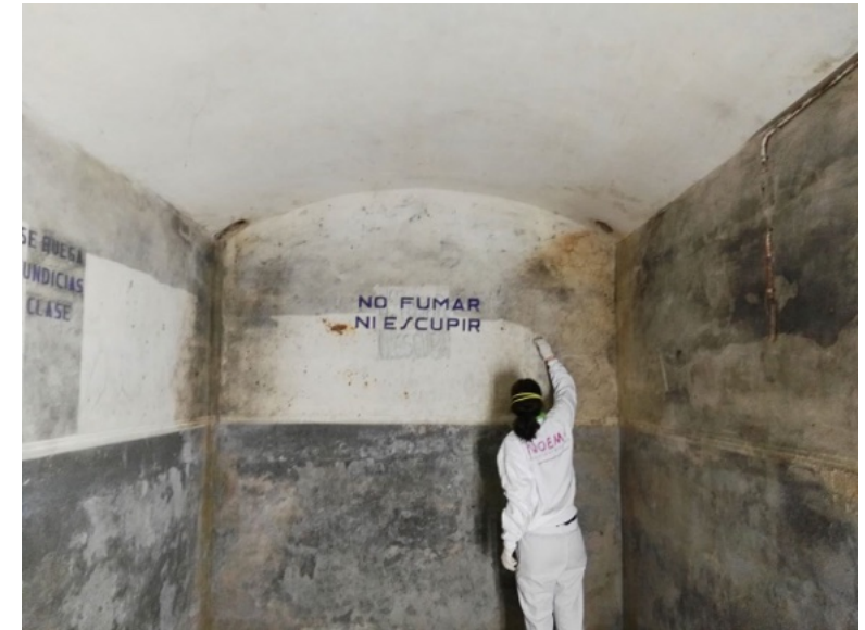
Limpieza con el uso de gomas de pan para eliminar estrato de hollín.
