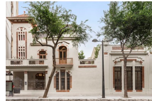
Fachada del pabellón de residencia del encargado y el guardián de la fábrica de Bombas GEYDA. Foto: Frank Gómez.
