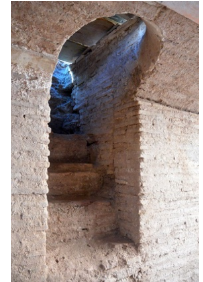
La escalera de acceso a la bodega una vez liberada de tierra y escombros. Foto: P. Berrocal Ruiz.
