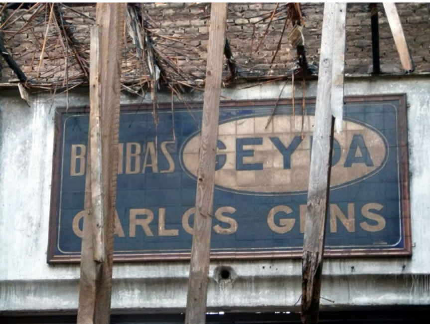
Panel publicitario de Bombas GEYDA en su ubicación original. Estado inicial antes de su intervención. Foto: Cercle Obert.
