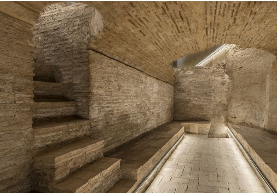
Interior de la bodega de la Alquería de Comeig. Foto: Frank Gómez.
