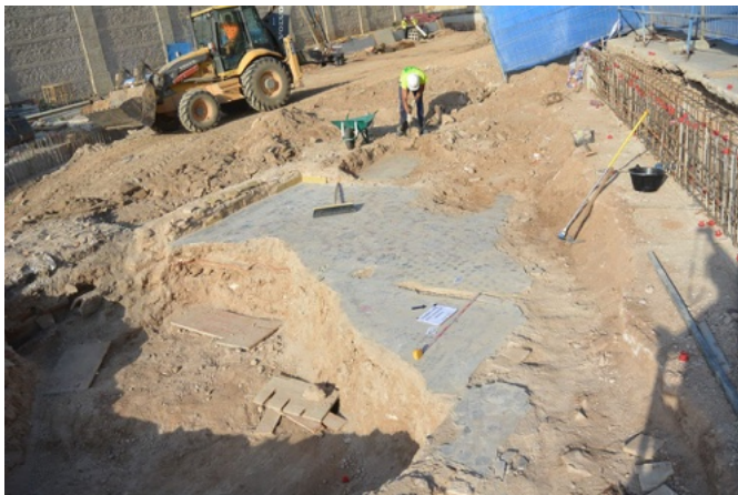
Aspecto que presentaban los pavimentos del siglo XX y arrasamiento de sus muros al comienzo de la excavación arqueológica. Foto: P. Berrocal Ruiz.
