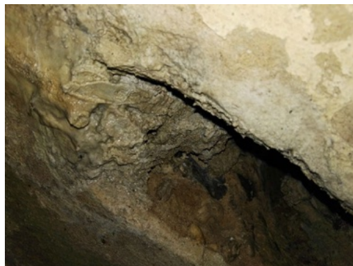
Manchas de carbonatación de sales, disgregación de estratos y estratos de recarbonatación en superficie.
