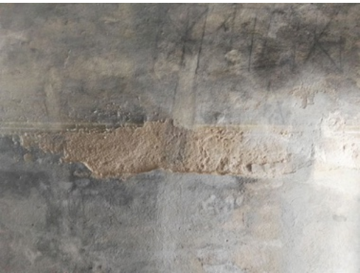
Manchas de carbonatación de sales, disgregación de estratos y estratos de recarbonatación en superficie.
