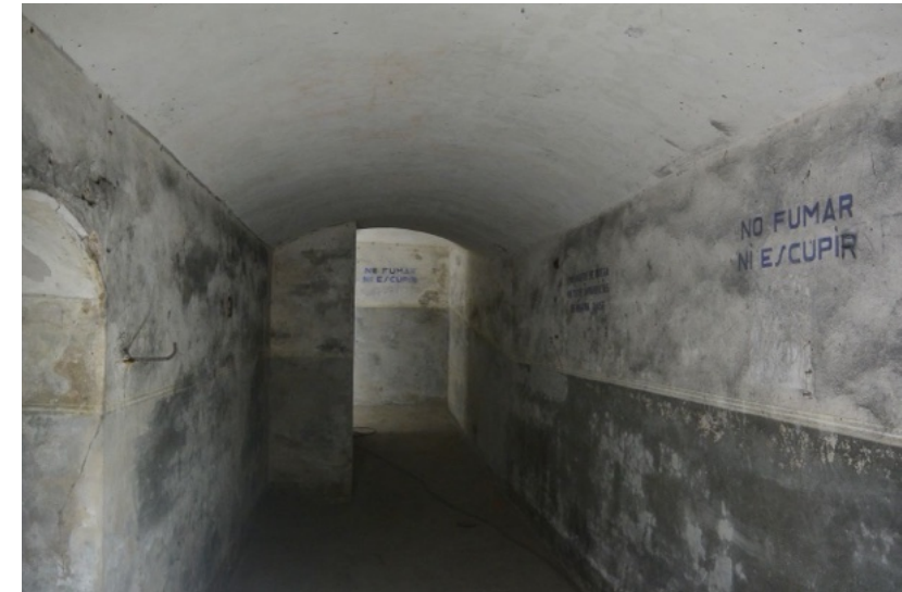
Vista general del refugio antes de la intervención.
