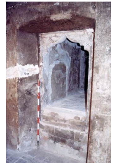
Puertas con arcos tardogóticos de los dormitorios del piso superior de la Alquería de Félix durante el proceso de intervención arqueológica. Foto: Víctor M. Algarra Pardo.
