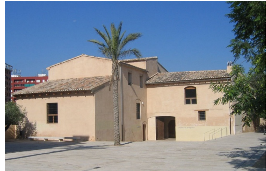
Fachada principal de la Alquería de Barrinto tras su rehabilitación. Foto: Víctor Algarra M. Algarra Pardo.
