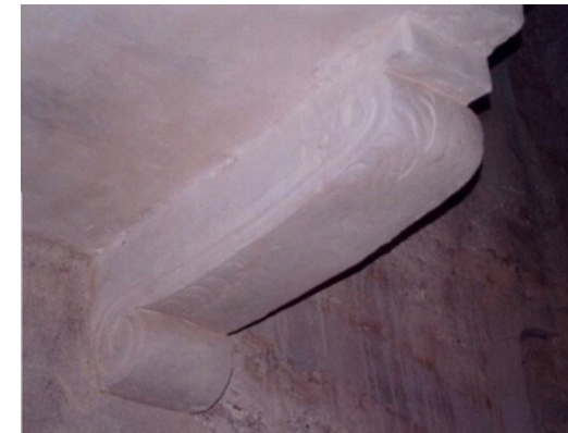
Detalle de la ménsula con decoración de tipo vegetal de volutas en relieve de la escalera. Foto: Víctor Algarra M. Pardo.
